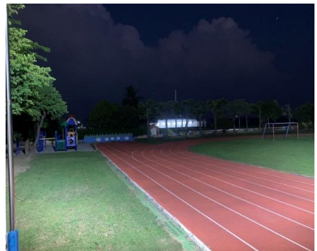
操場照明設備
