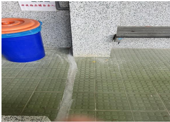
冷氣排水管的工程 2
