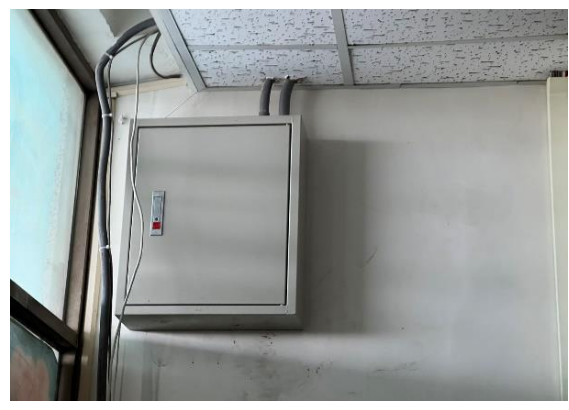
新設電箱的修繕 2
