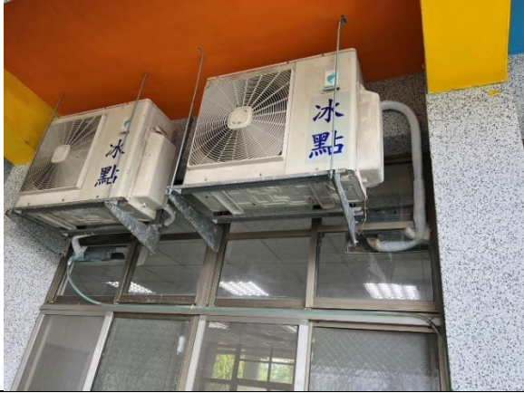
冷氣移機至辦公室
