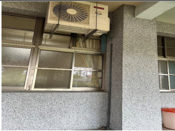
冷氣排水管的工程 1
