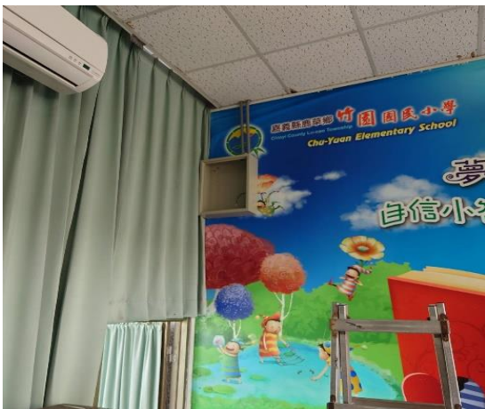
新設電箱的修繕 3
