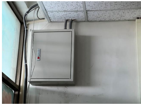
新設電箱裝設
