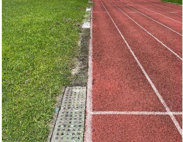
水溝格柵新增不鏽鋼
