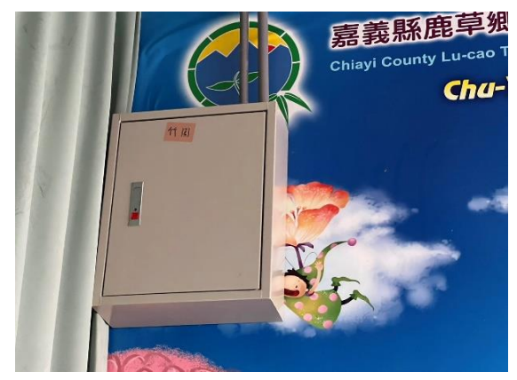
新設電箱裝設
